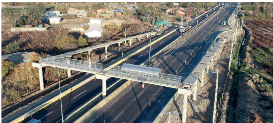
Sector Pasarela Peatonal y Paraderos Putagán Sur, Km 292.850
