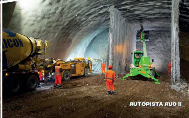
SHORTCRETE UNICON LÍNEA 7 - METRO SANTIAGO
