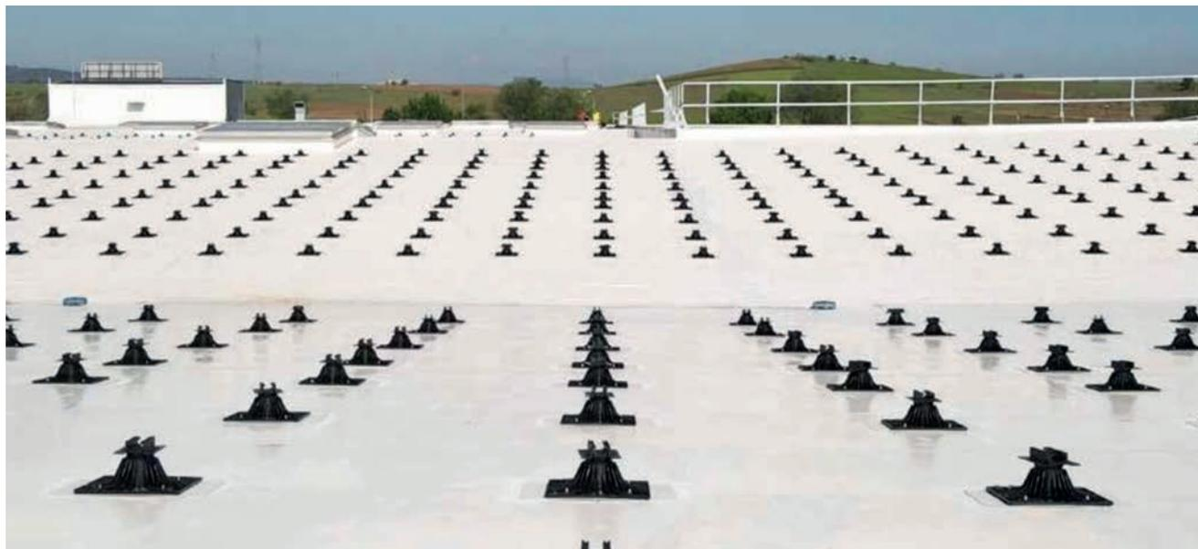
*"Los sistemas SOPRASOLAR® utilizan materiales ligeros y duraderos, como el aluminio y la poliamida reforzada, garantizando una instalación segura y eficiente"*
