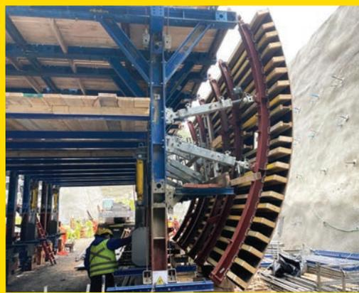
Sistema SL-1 para túnel en
