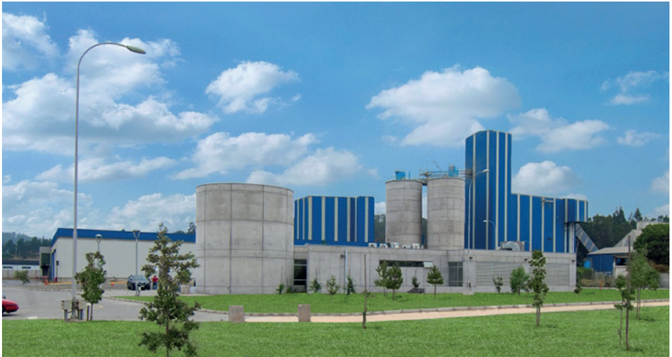
Planta de cemento en San Juan de Lillo, San Antonio, V Región.
