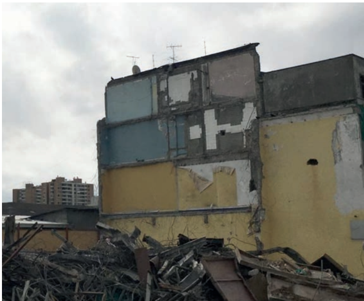
Fig. 3 Vestigios de habitabilidad de un edificio demolido y material acopiado para recuperación. Archivo Anamaría De León
