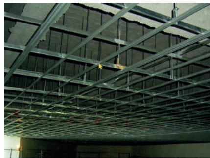
Travesaño del techo
