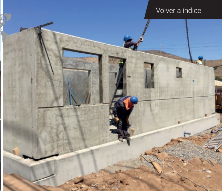
Solución 100% prefabricada desde segmento social a privado de alto estándar con fundaciones, radier, muro y losa prefabricadas de hormigón.
