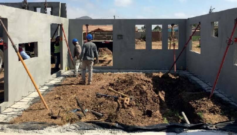
Solución solo muros de vivienda en la que el cliente ejecuta en terreno las fundaciones y radier.
