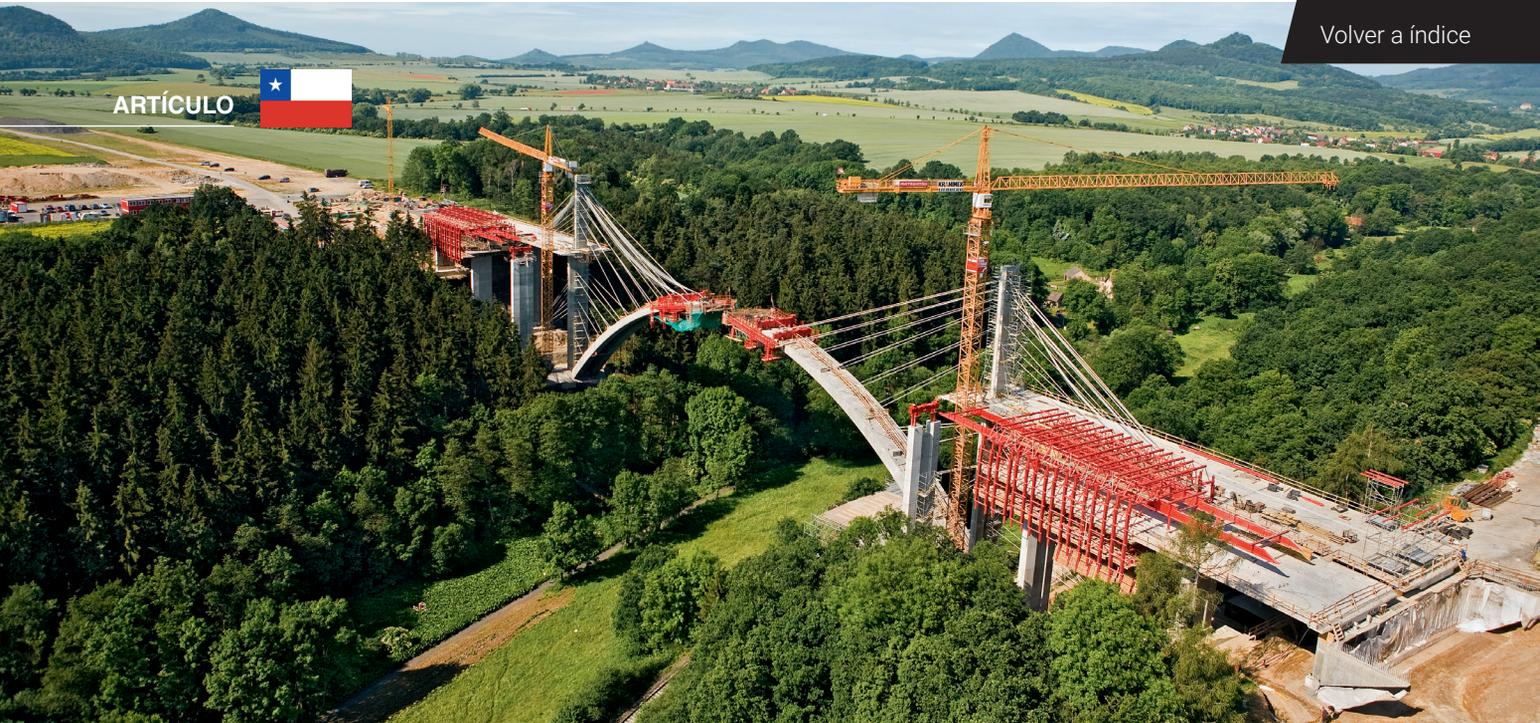
los diferentes procesos de trabajo, como la rehabilitación y el hormigonado, pueden llevarse a cabo de forma muy segura, lo que hace que la VGK sea especialmente adecuada para trabajos de restauración.
