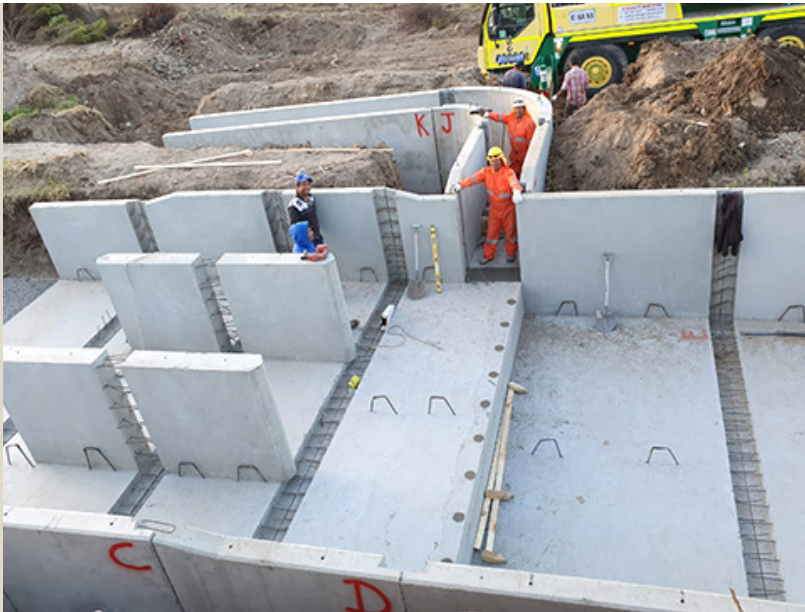
Revestimiento canal regadío con prefabricados de hormigón
